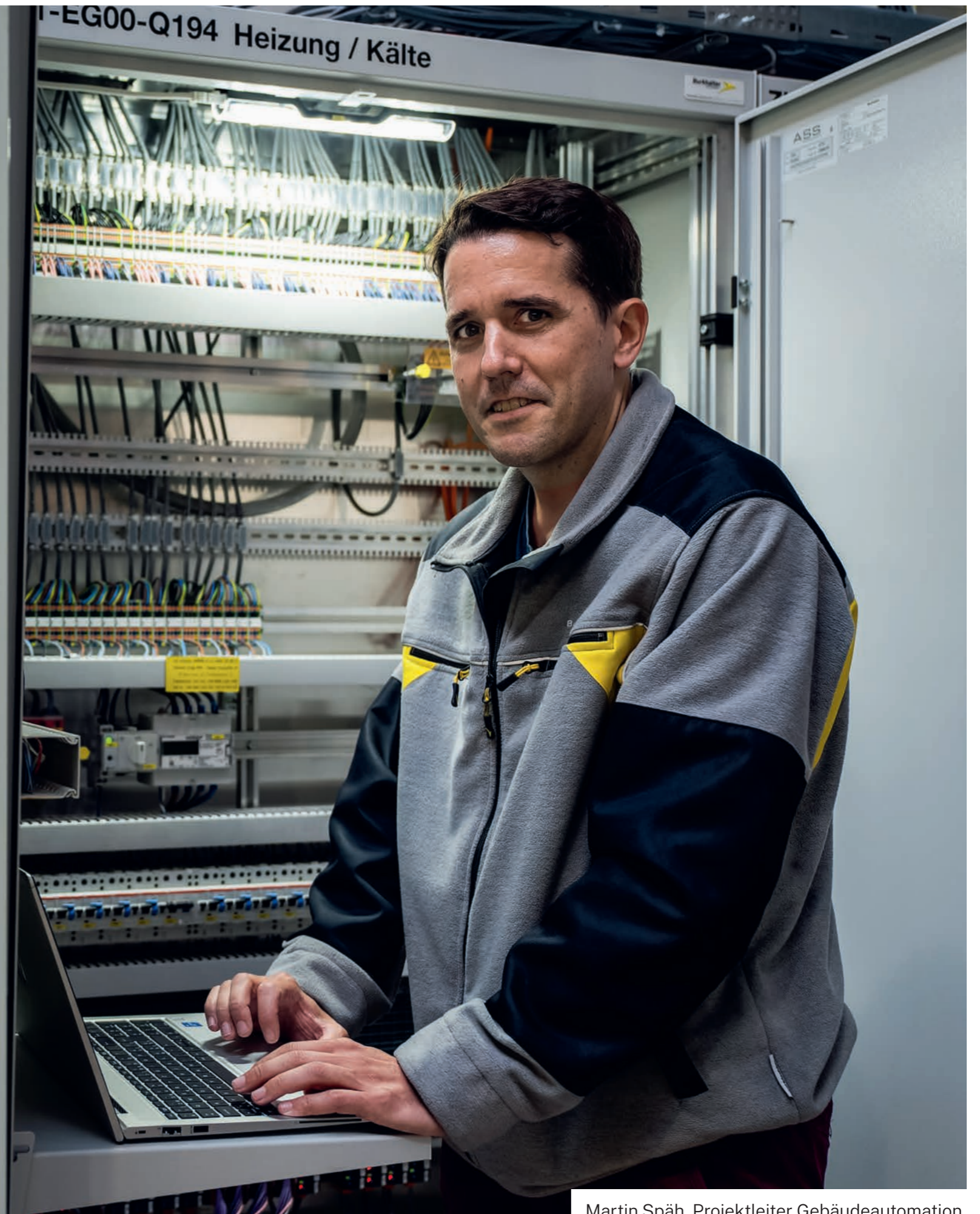
Martin Späh, Projektleiter Gebäudeautomation.
