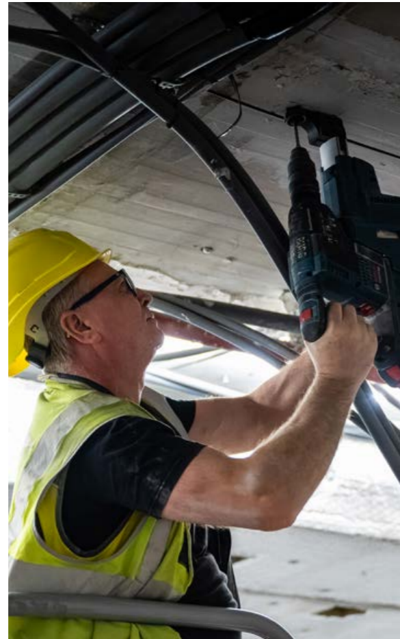
Hinter den Kulissen erstellen die Gelben temporäre Installationen für den Baustellenbetrieb.
