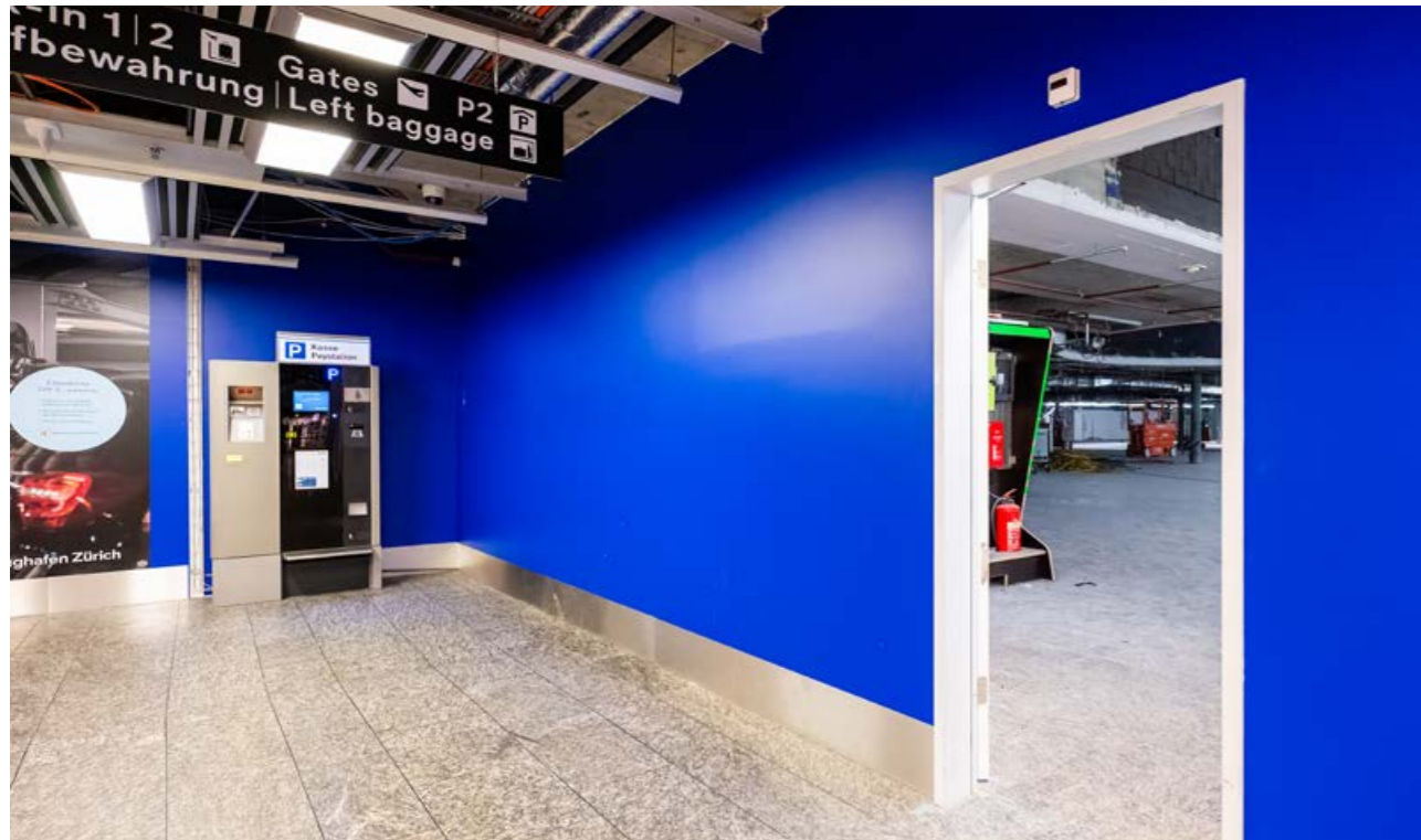
Temporäre Bauwände und Türen trennen Baustelle und Publikumsbereich.
