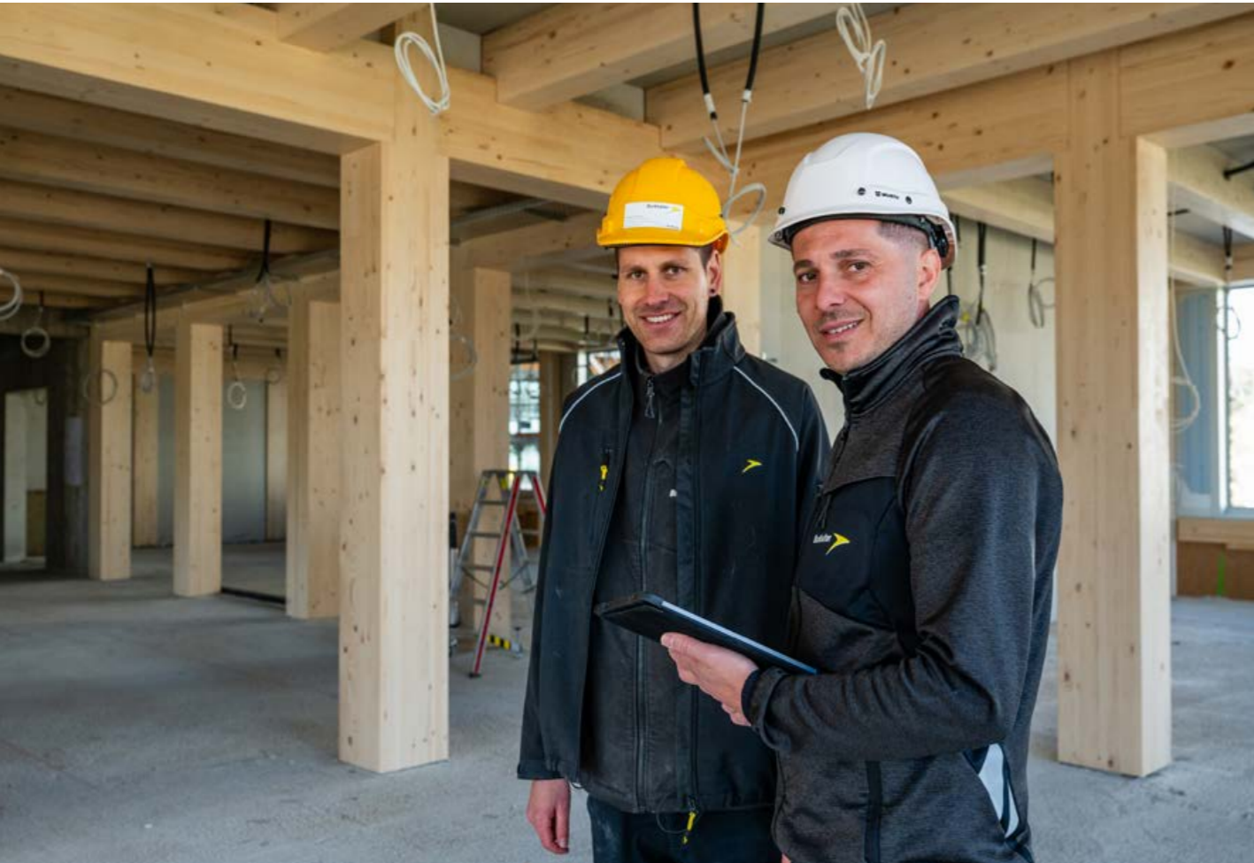
Projektleiter Dzevair Bedzeti (rechts) und bauleitender Elektroinstallateur Simon Schüpbach.
