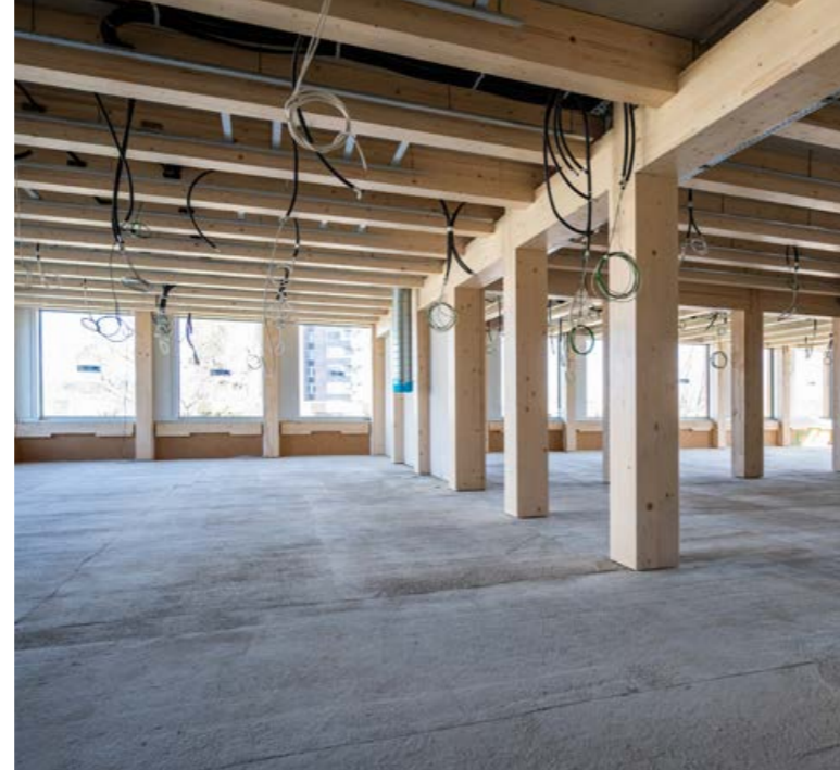
Darunter statt darin: Die Verbunddecke zwingt dazu, die Leerrohre zwischen den Holzträgern zu verlegen.
